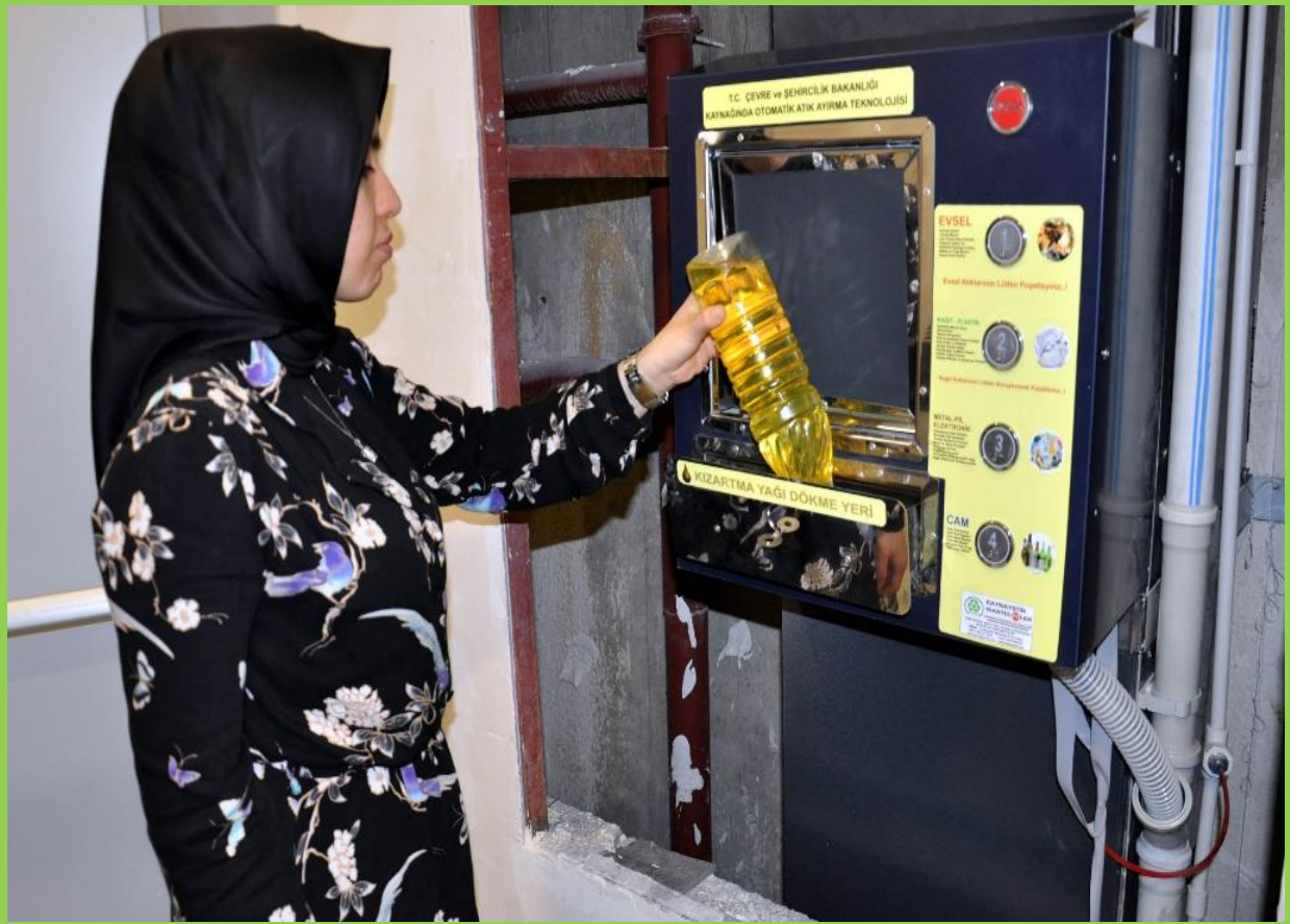
Kızartma yağı çekmecesi özel olarak atık kızartma yağlarını merkezi depoya iletir. Yağdanlık süzgeçleri kolaylıkla çıkarılıp -yıkayıp -yerleştirilmektedir.
